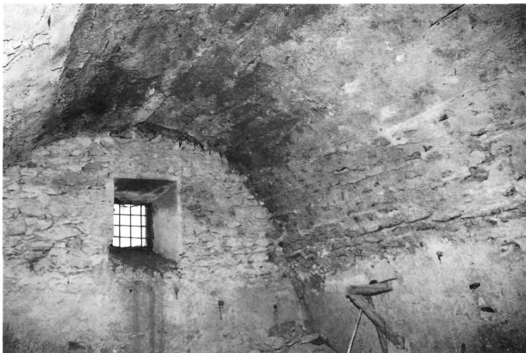
Imatge de l'interior de la torre a nivell de la planta baixa. S'observen perfectament els materials de fàbrica i la tècnica constructiva d'aquest element, a base de murs de maçoneria i una volta feta a partir d'un encofrat. La fotografia correspon a l'edificació més antiga de la casa, probablement del segle XIII o XIV. (Núria Payán).
