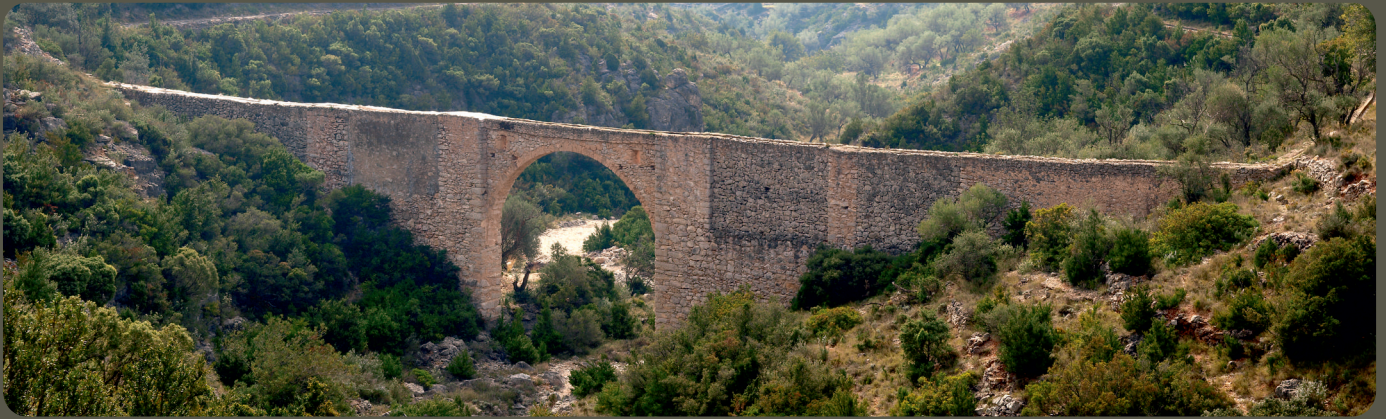
Pont de les Canals a la vall dels Ports, barranc de l'Àliga, Mas de Barberans, 2009. Foto i fons: Josep Maria Ventura.
