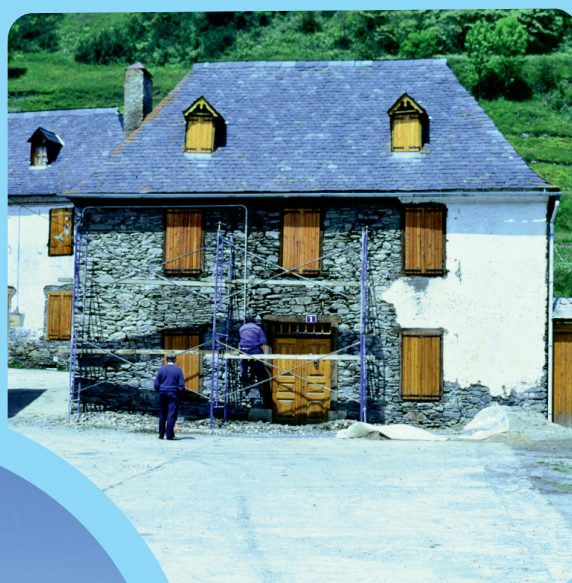
Repicat de l'arrebossat d'una façana, Arres de Jos (Val d'Aran), 1989. Foto i fons: Ferran Estrada.
