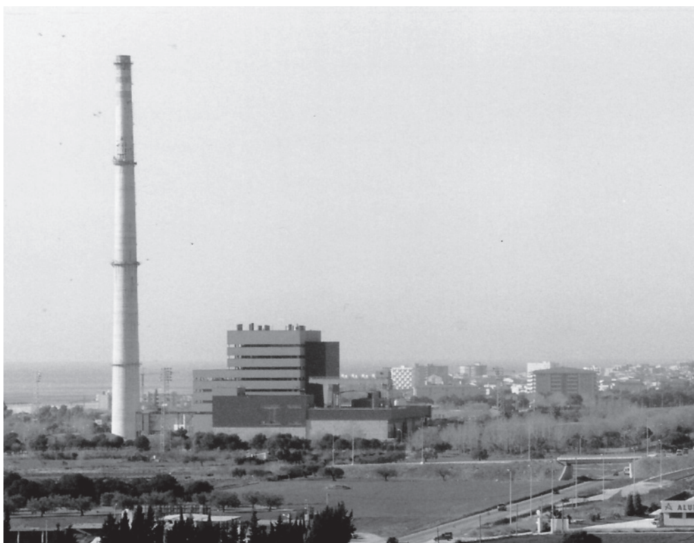
Central tèrmica acabada. Dècada dels 80. Font: APAPG.
